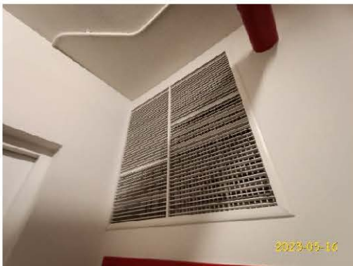
ระบบระบายอากาศของลิฟต์ดับเพลิง
