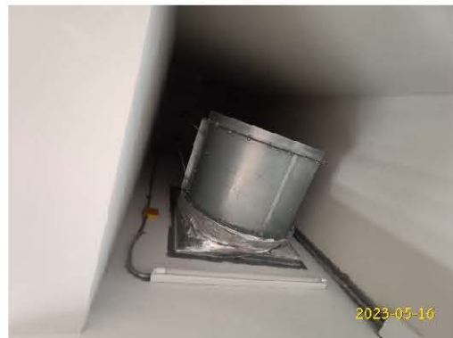
ระบบระบายอากาศของลิฟต์ดับเพลิง
